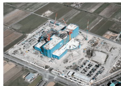
建築中の新病院
